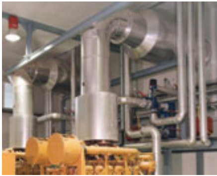
Figura 2. Coquilla de fibra de vidrio.
